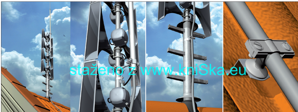
Obr. 2. Příklad instalace s izolovanými vodiči
